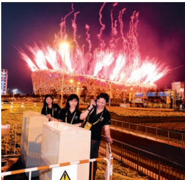
2008年8月8日，保电队员在巡视奥林匹克中心区的供电设备
