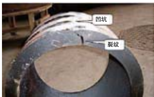
图2 用主蒸汽管道开裂
