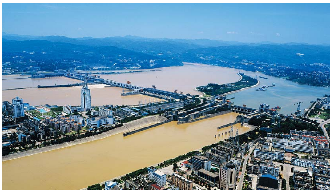
■ 葛洲坝水电站第一台机组于1981年投产，1989年全部建成，总装机容量为271.5万kW，是当时我国最大的水电站。图为葛洲坝电站鸟瞰图
