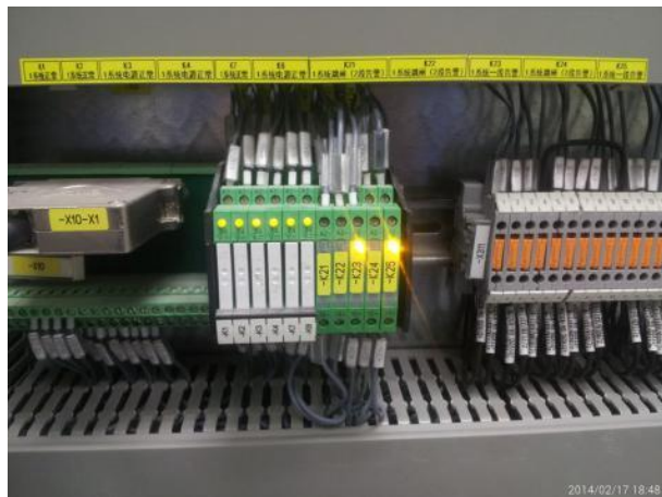
阀厅避雷器接口屏照片
