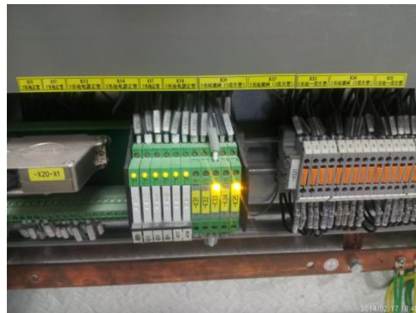
阀厅避雷器接口屏照片
