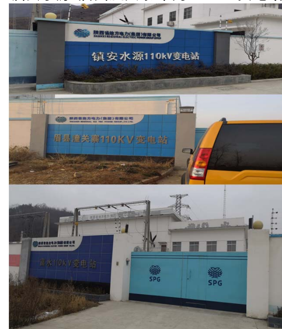
陕西地方电力 镇安水源/眉县潼关寨/富水110KV变电站
