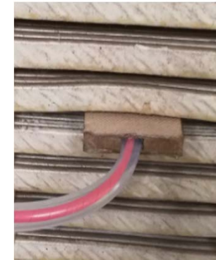
辐向垫块在绕组上的安装
