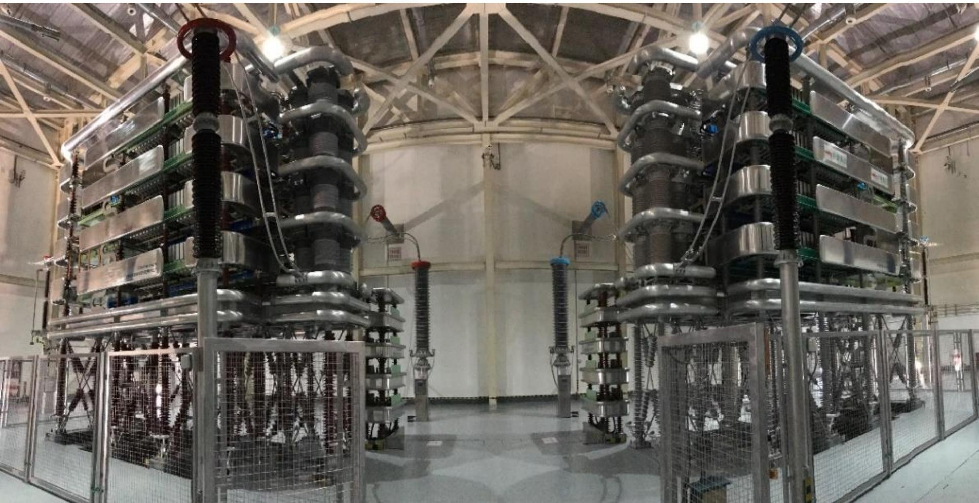
舟山工程舟定站正、负极200kV直流断路器
