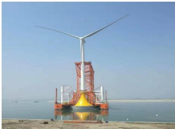
复合筒形基础一步式安装技术
