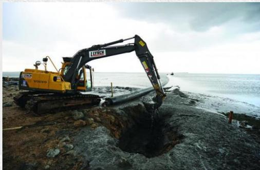
泰晤士河河口的伦敦阵列风电场电缆，在铺设第二条电缆的过程中，被风机安装平台的支腿损坏。
