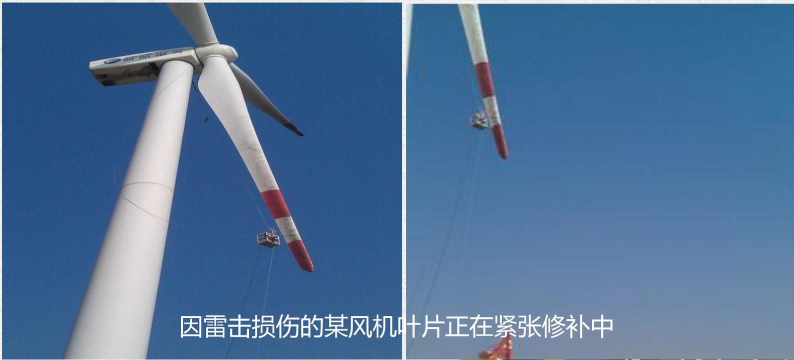
因雷击损伤的某风机叶片正在紧张修补中
