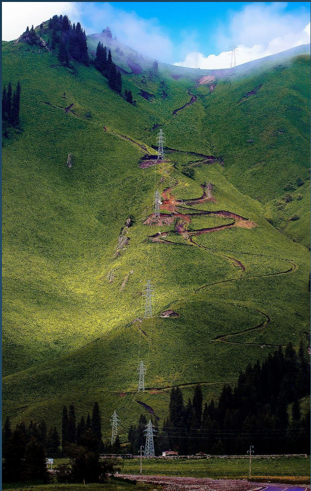
跨越天山的高压输电塔
