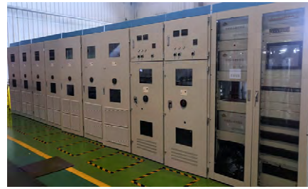
图 20 四端口 HFB-EER 工业样机
