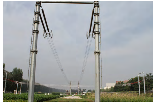
图1 户外交叉跨越直流试验线段
