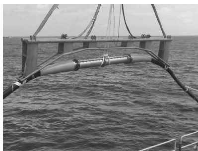
图 10 硬接头吊放
