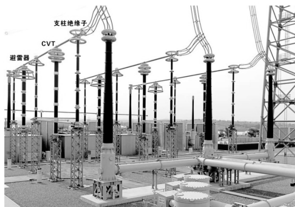
图6 运行中的特高压避雷器和 CVT
