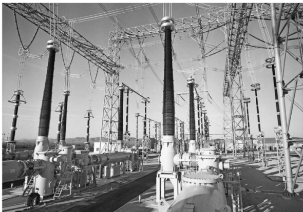
图4 运行中特高压 GIS 开关设备
